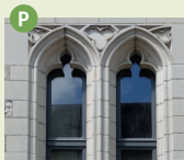
Couvent des Viantaises Bâtiment XV e
