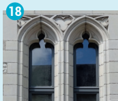
Couvent des Viantaises Bâtiment XV e
