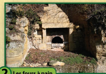
2 Les fours à pain
